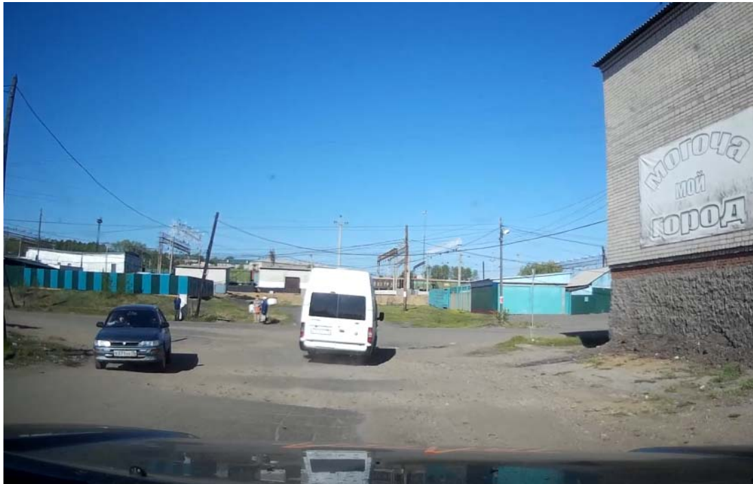
Рисунок 3.6 – Частичное отсутствие твердого покрытия на Вокзальной ул.
