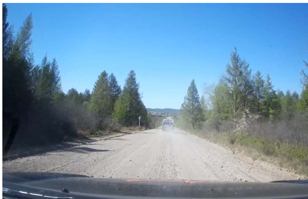
Рисунок 3.3 – Отсутствие твердого покрытия в конце Тракторной ул.
