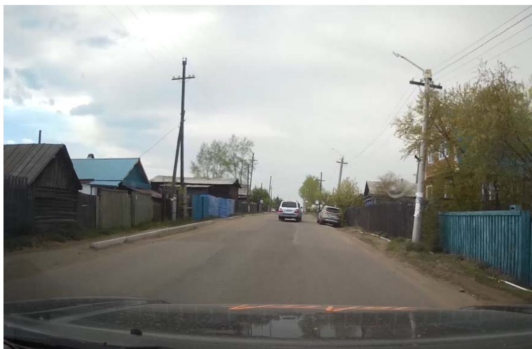
Рисунок 3.1 – Отсутствие разметки на Украинской ул.
